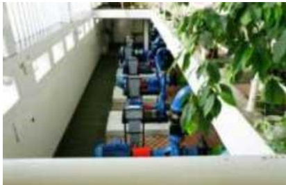
Vízmű I., szivattyúház
